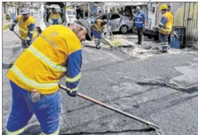
Trabalho de recapeamento asfáltico em Nilópolis
