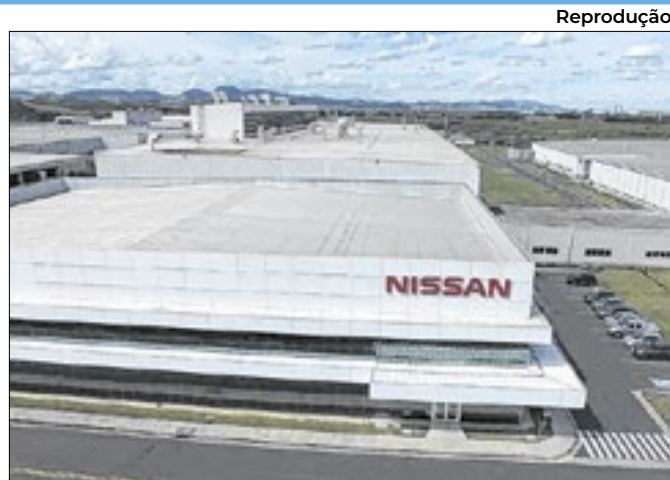
Sede da Nissan, localizada no município de Resende
