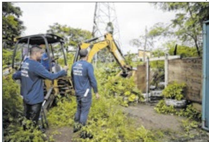
Construções estavam próximas de linhas de transmissão
