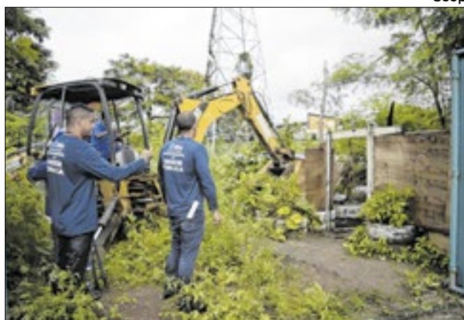
Construções estavam próximas de linhas de transmissão
