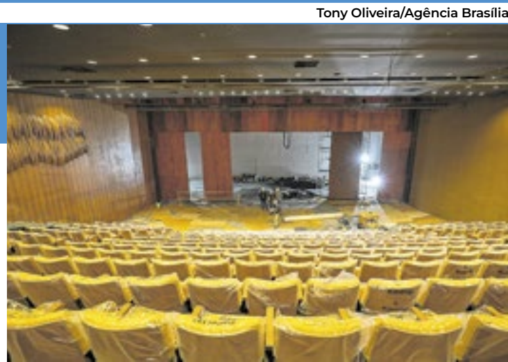
A sala Martins Pena está praticamente concluída. Estão sendo feitos os ajustes e acabamentos finais
