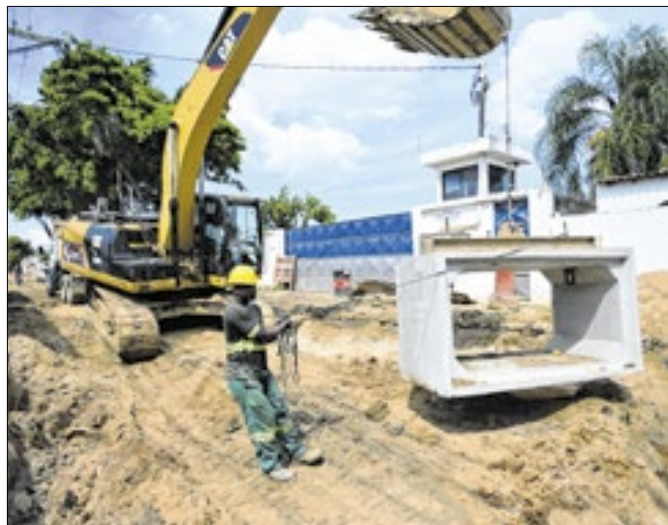
Obras de saneamento e urbanização na Tapera
