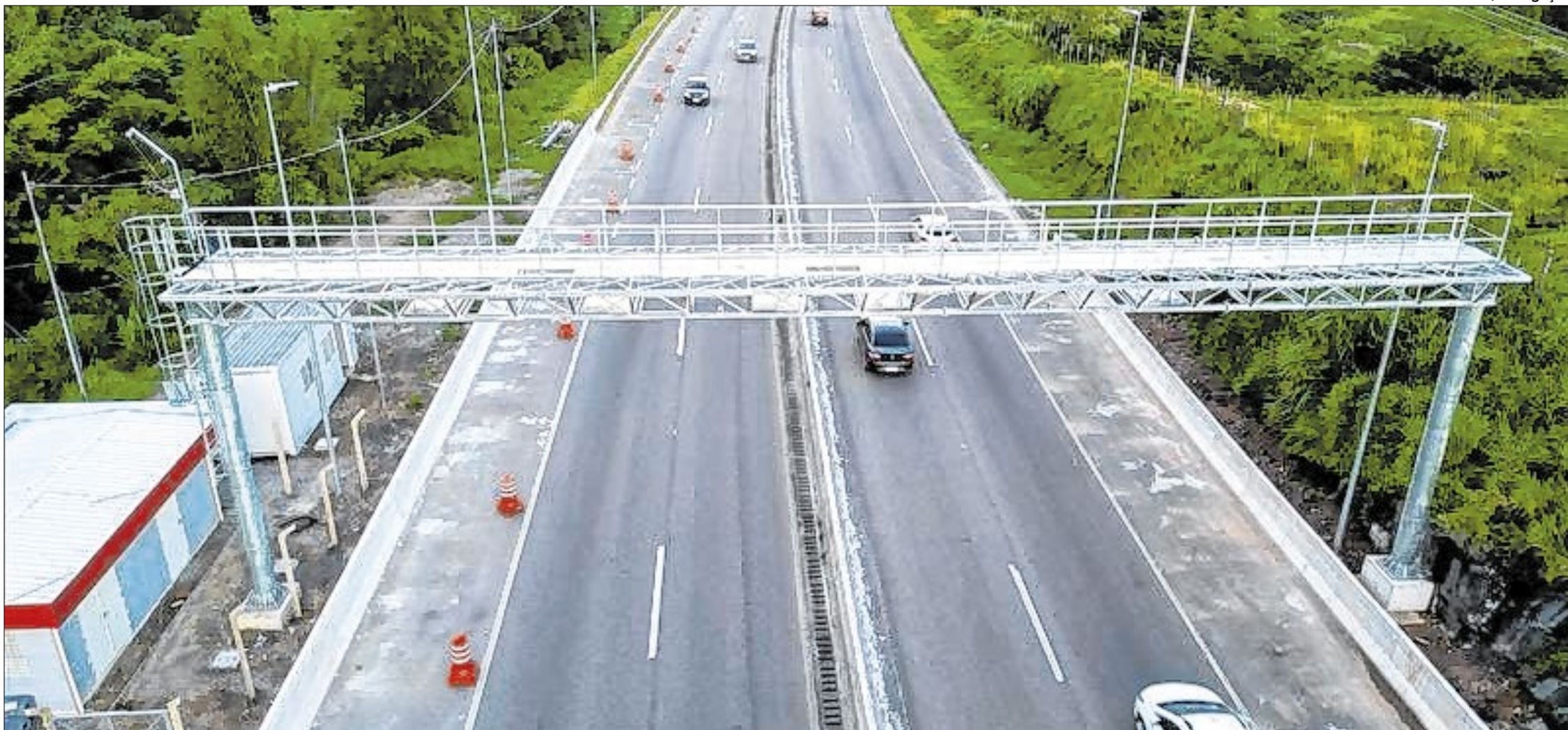
Rio-Santos tem pedágios automatizados e enfrenta problemas de deslizamentos
