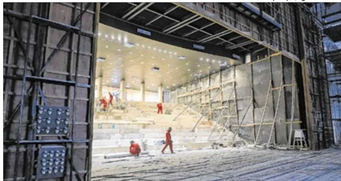
Primeira parte da reforma está sendo concluída para reabertura parcial
