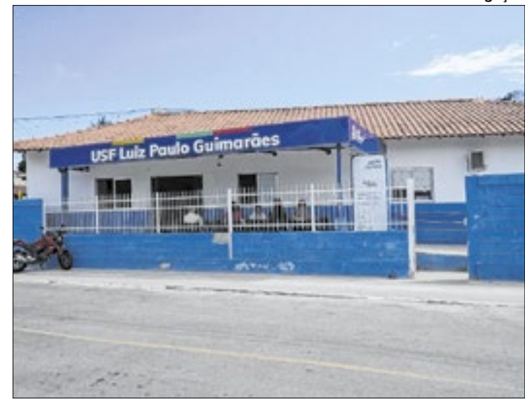
USFs receberam reformas estruturais e adequação
