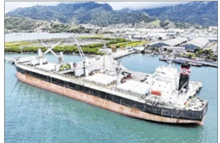
O objetivo das obras é reforçar a segurança da operação
