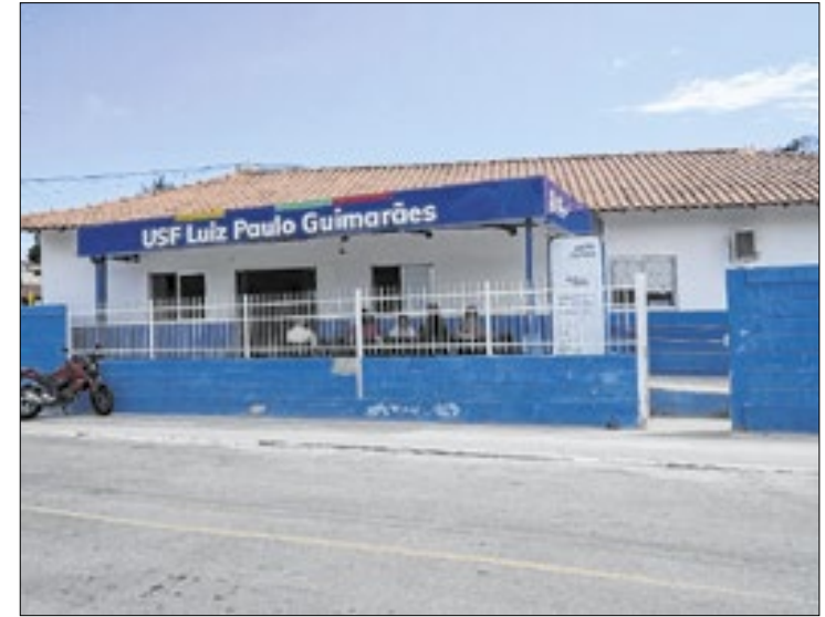
USFs receberam reformas estruturais e adequação
