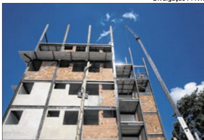
Vigas e colunas começaram a ser assentadas
