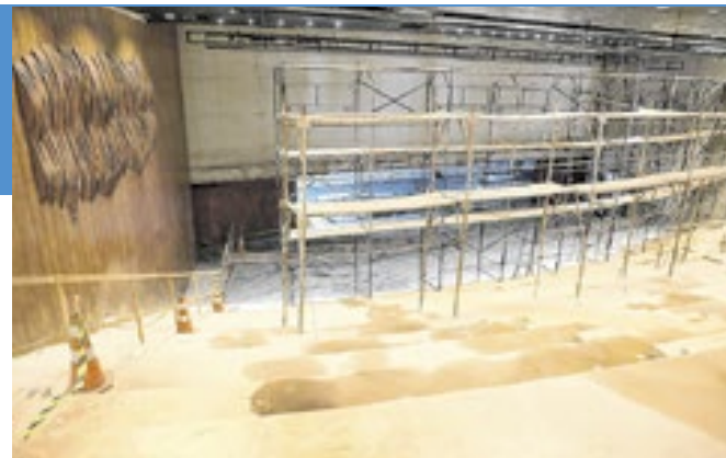
A Sala Martins Pena está na fase de acabamento
