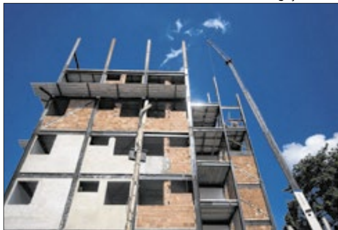
Vigas e colunas começaram a ser assentadas
