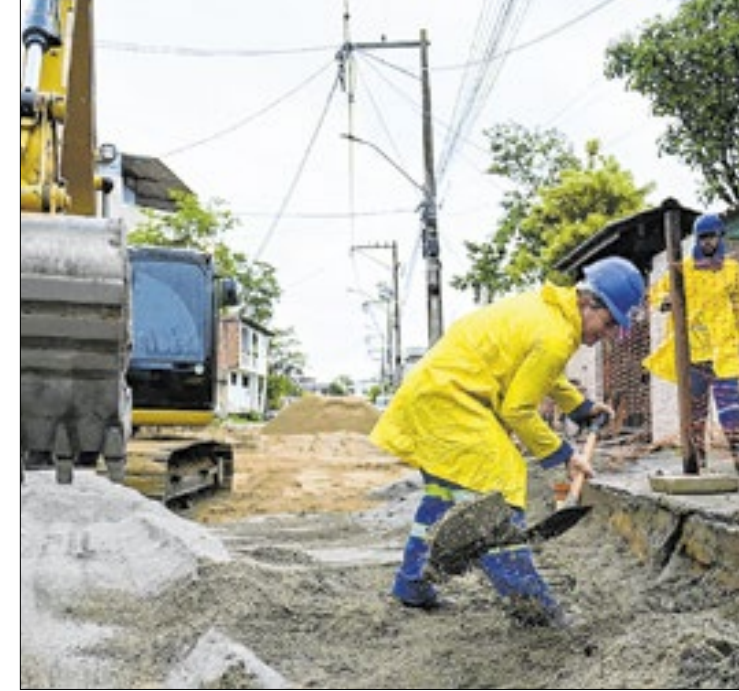
Ruas são escavadas e recebem estrutura de saneamento
