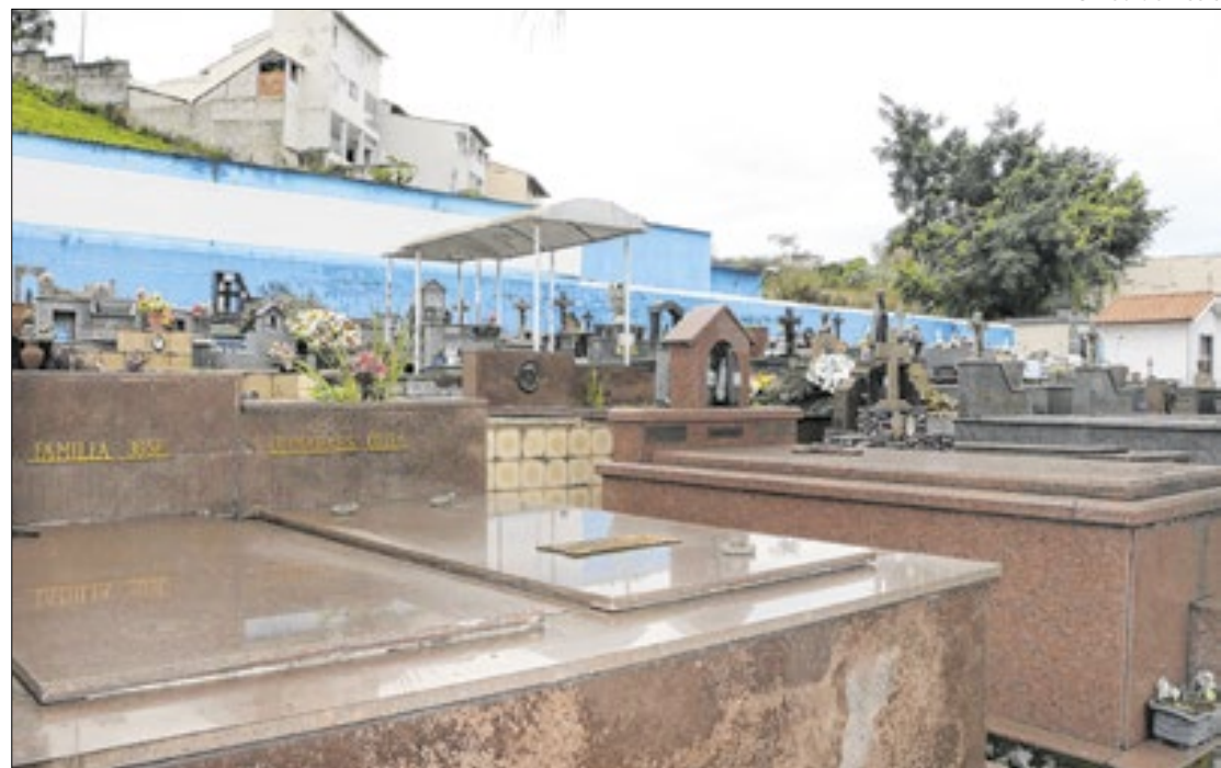
Cemitério Municipal de Barra Mansa recebeu série de restaurações e reparos
