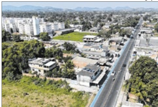
Obras são realizadas em Duque de Caxias
