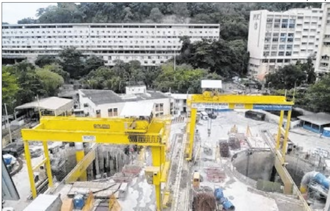
Obras na estação de metrô da Gávea, na Zona Sul do Rio
