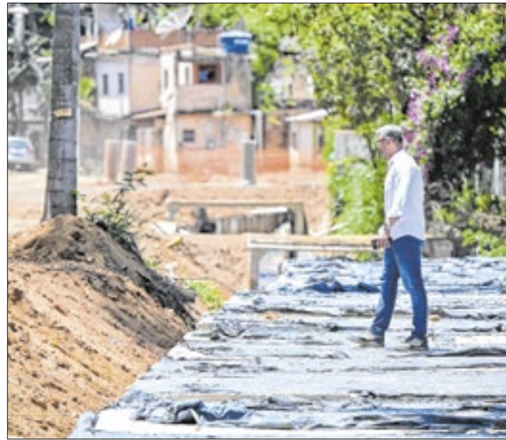
Trabalhos vistoriados incluíram pavimentação e reforma
