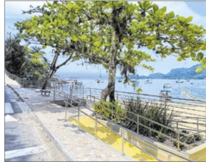
Praia Grande recebe obras de acessibilidade e revitalização
