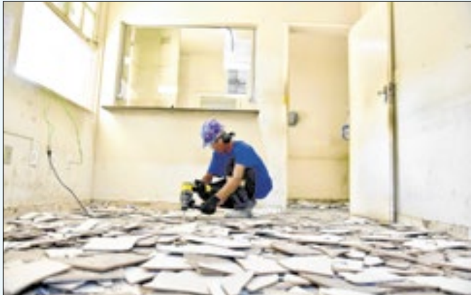
Campos avança com obras em unidades de saúde
