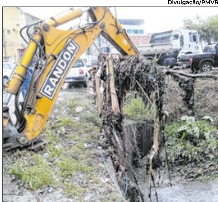
Servidores limpam ruas, removem entulhos e lama
