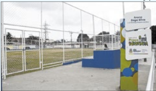
Praças estão sendo reformadas em São Gonçalo
