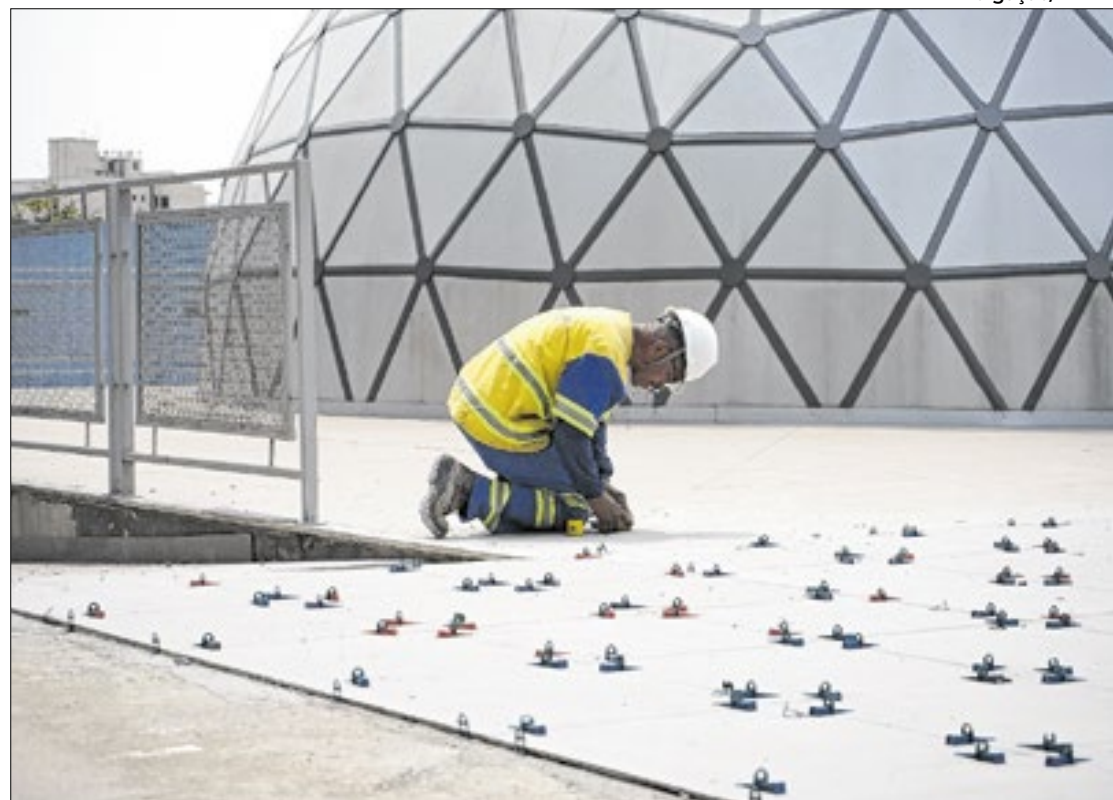
Obra civil de Museu de Ciência e Tecnologia de Volta Redonda será concluída em dezembro, segundo prefeitura
