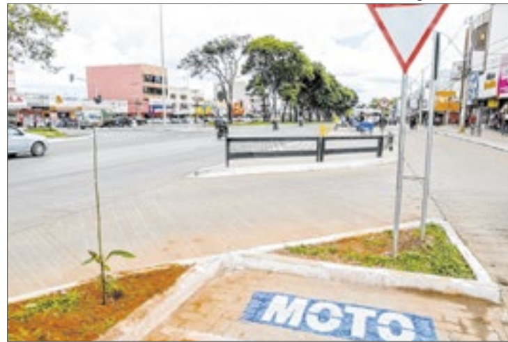
Primeiro trecho da Hélio Prates foi concluído em maio do ano passado
