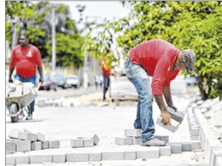
Obras já mudaram o aspecto do local em Campos
