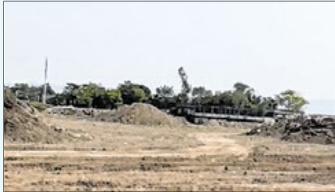
Espaço está sendo construído no bairro São Bento
