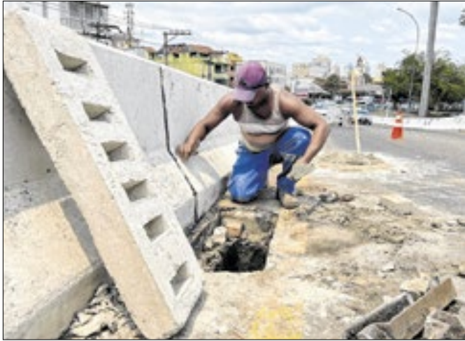
Serviços de drenagem ocorrem na Ponte Leonel Brizola
