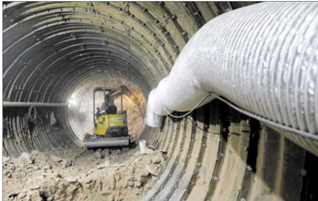
Obras do Drenar-DF estão 95% concluídas e devem ser concluídas até o final do ano
