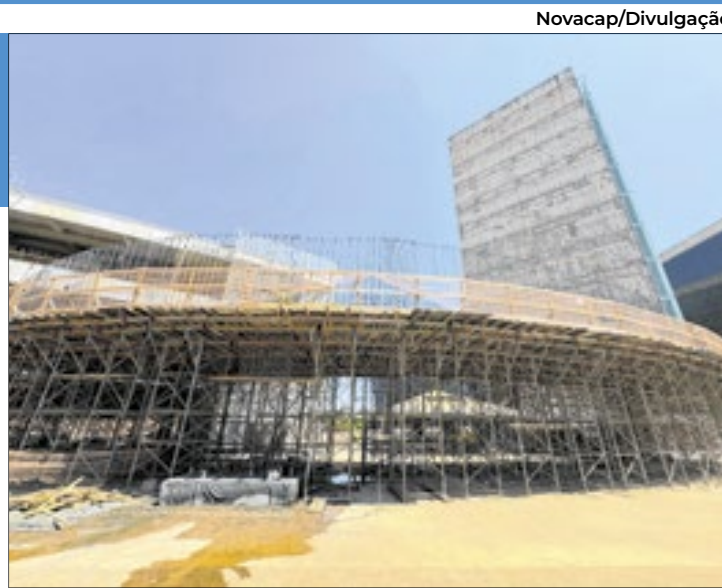
A rampa, inclinada e em declive, ligará dois prédios da nova sede do TRF-1
