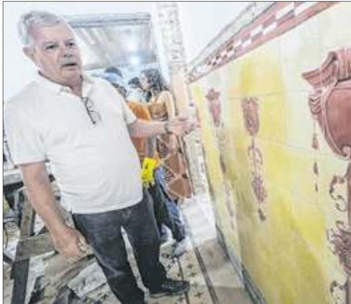
Prefeito Axel Graef durante a vistoria das obras
