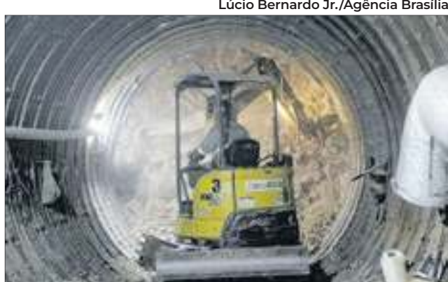
Diante do solo rígido, a alternativa foi recorrer ao uso de escavadeiras e furadeiras hidráulicas
