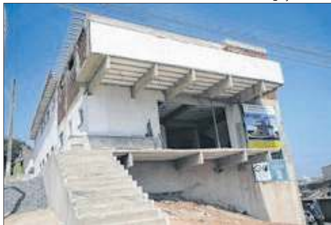
Construção está com as instalações elétricas adiantadas
