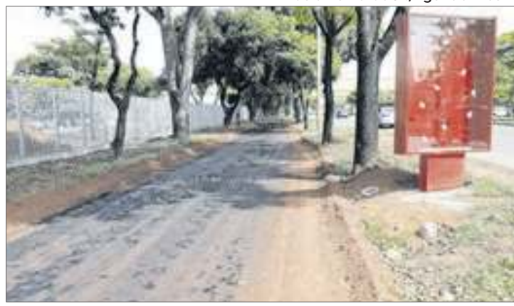
No Pistão Sul, em Taguatinga, a instalação de mais um painel aproveitou a obra da nova ciclovia
