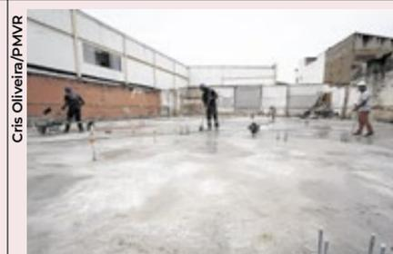
Obras da futura sede da Secretaria da Pessoa com Deficiência de Volta Redonda têm a primeira laje concluída. Para a próxima etapa, haverá a instalação das vigas e pilares, de estruturas metálicas.
