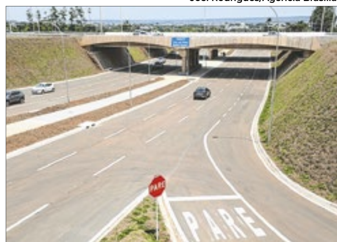
Robério Negreiros apresentou emenda à LDO que viabilizou a construção do viaduto do Sudoeste
