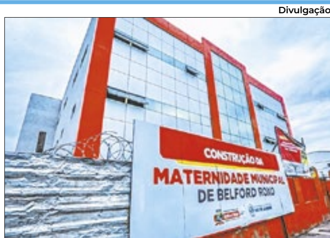
Belford Roxo avança com obras da Maternidade Municipal
