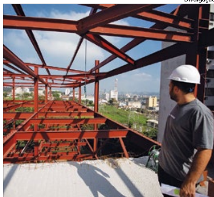
Obras do Hospital São João Batista, em Volta Redonda
