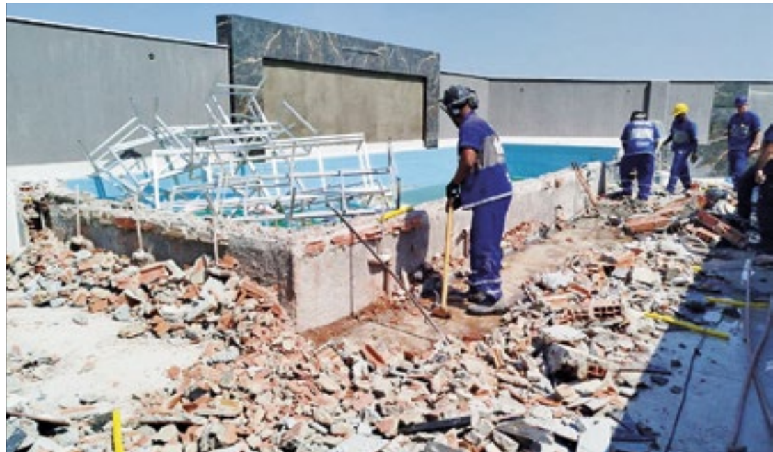
Demolição em série paralisou escolas e unidades de saúde na Maré
