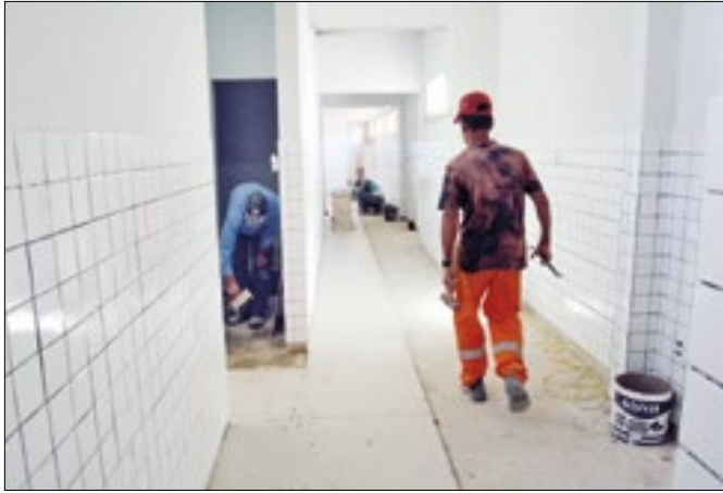
Obras na Sirene da Vila Nova estão em fase avançada
