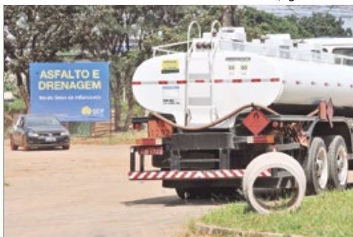
Obras de recuperação e de ampliação da malha rodoviária do DF fazem parte do portfólio do DER
