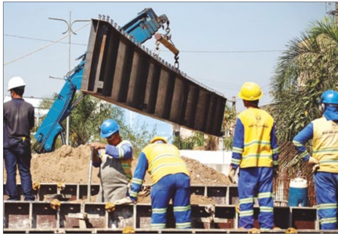
Obra faz parte do Plano de Mobilidade Urbana do município, em parceria com o Estado
