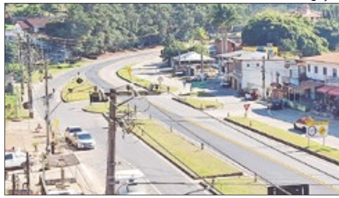
Concessionária removeu as placas instaladas no local
