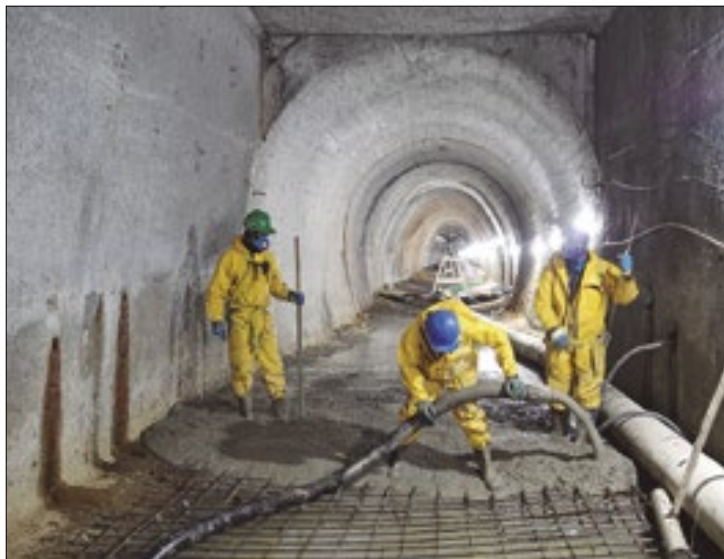
As obras no túnel com finalização programada para 2025
