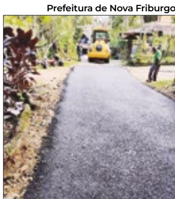
Pavimentação da via
