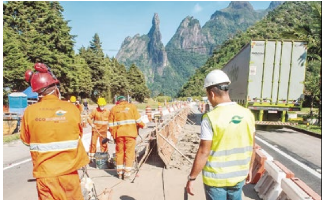
As obras começaram na segunda quinzena de junho e serão entregues no fim deste mês
