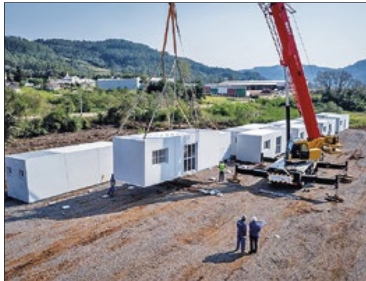
Unidades estão sendo instaladas em Palmas e São José
