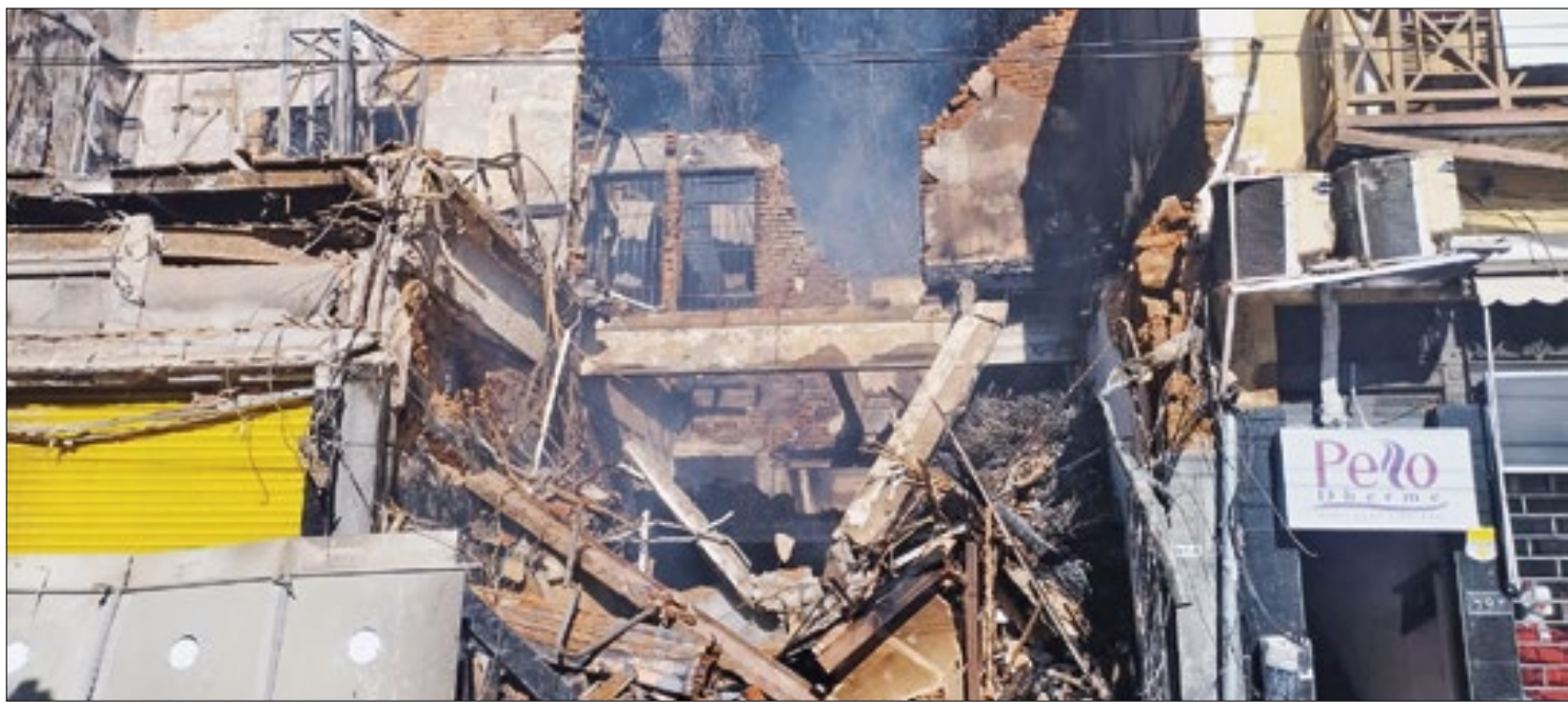
Órgãos de tombamento estão acompanhando os desdobramentos após mais um incêndio no Centro Histórico de Petrópolis
