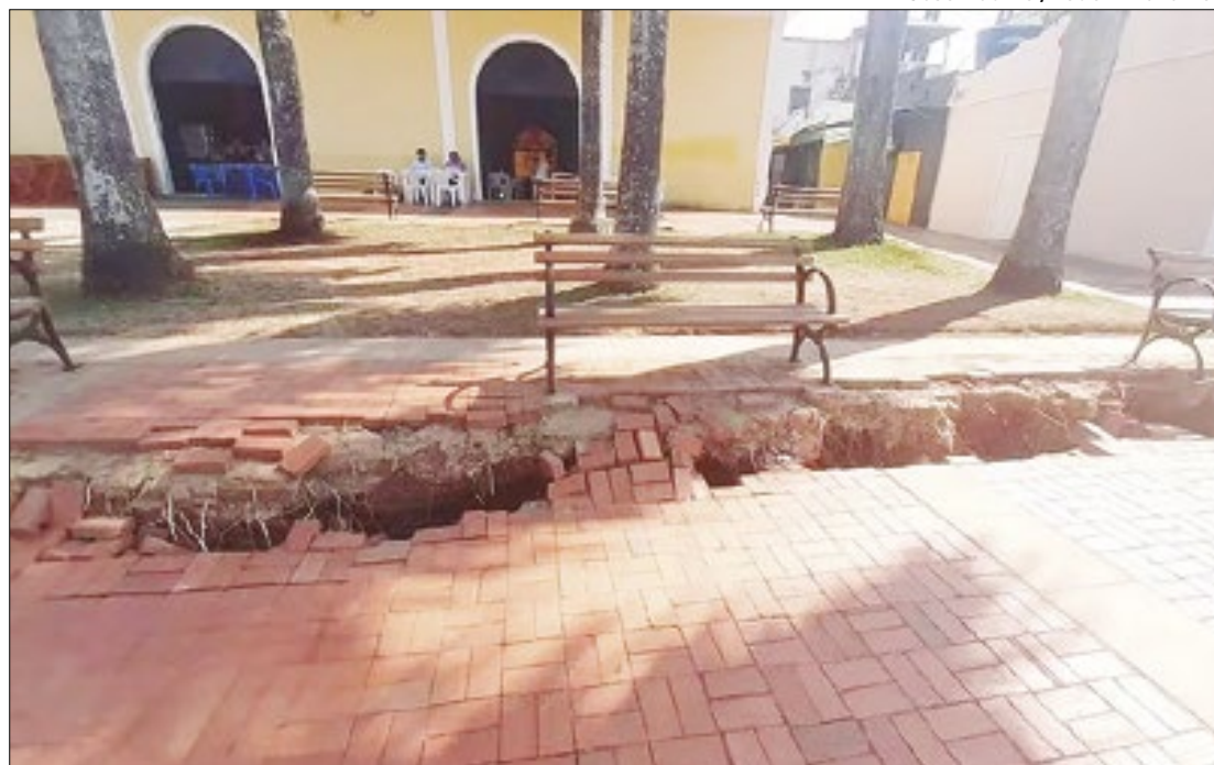
Novo Mercado Velho apresenta problemas ocasionados pela cheia e seca do Rio Acre
