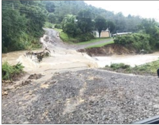
Ação é parte do esforço de recuperação de danos
