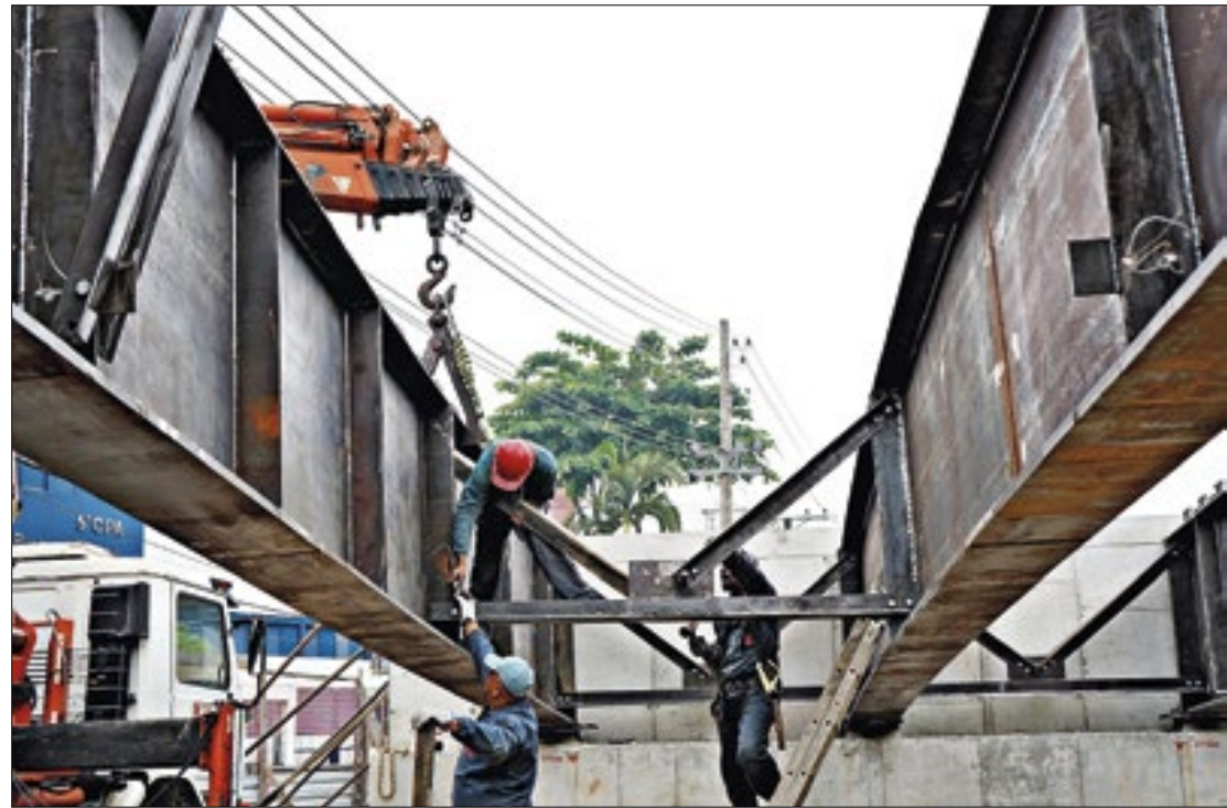
Obra faz parte do Plano de Mobilidade Urbana, com investimento de cerca de R$ 140 milhões
