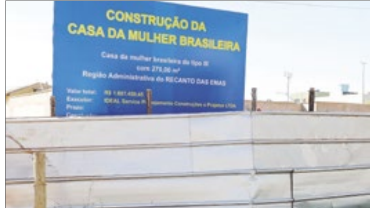
A expectativa é de que a Casa da Mulher Brasileira, em construção, beneficie cerca de 500 mil moradores da área sul do DF com serviços de acolhimento às mulheres e enfrentamento à violência de gênero
